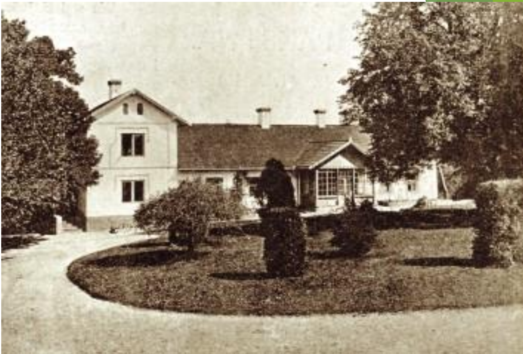
Dworek Marii Konopnickiej w Żarnowcu od strony południowej. (1903)
